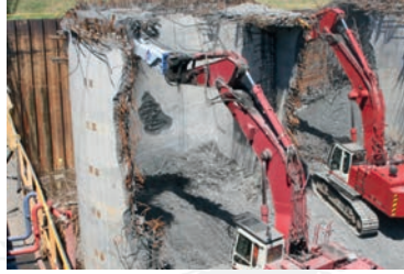
Demirli beton, ön gerilmeli beton, fiber destekli beton ve düşük ağırlıklı beton kırma
