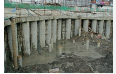
Temel kazıkları çakma
