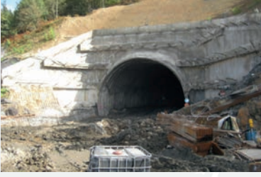
Tünel kazısı uygulamalarında
