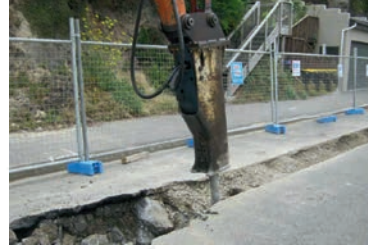
Asfalt, kompozit yüzeyler kırma, hendek, çukur ve toprak kazma
